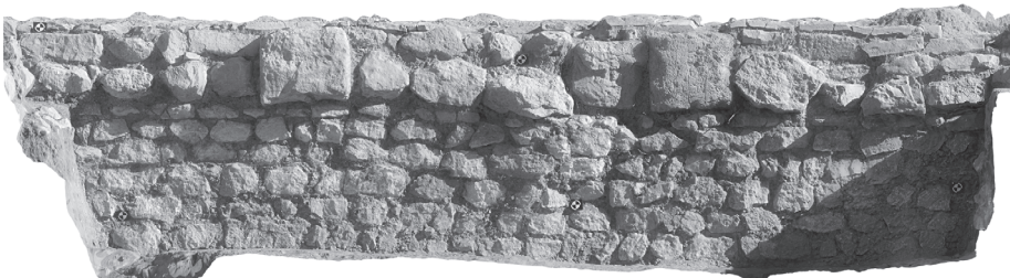
Fig. 5: Alzado fotogramétrico con los muros UUEE 1506 / 1526 y sillar con inscripción reaprovechado como material de construcción.
